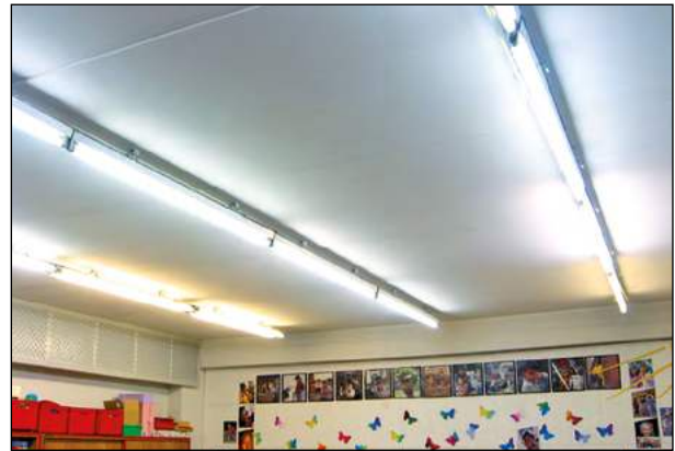
Bild: Deckenbeleuchtung mit Leuchtstofflampen
